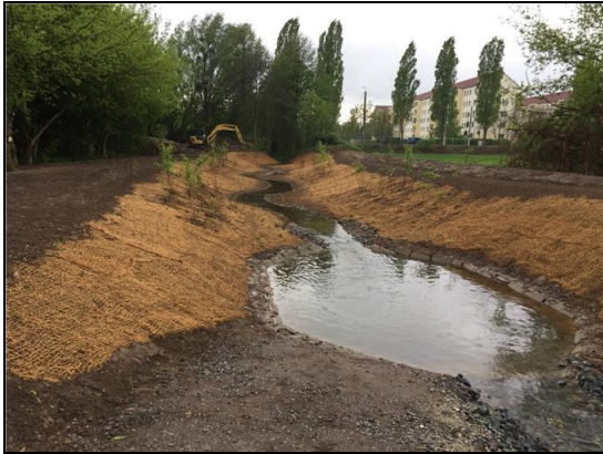
Abb. 9: Sedimentfang unterstrom Pirnaer Landstr. kurz vor Fertigstellung, 02.05.2017
