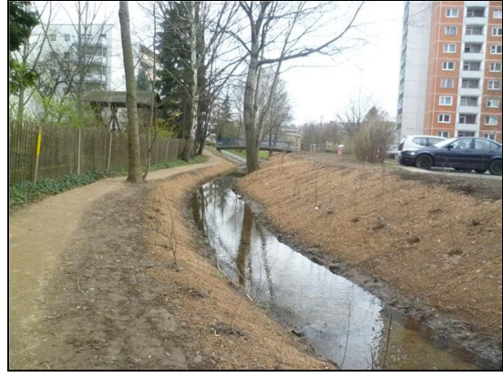
Abb. 8: Fußweg am neugestalteten und ingenieurbologisch gesicherten Gewässer, 23.03.2017
